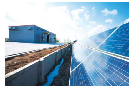
| 전남 영암 1.5MW 태양광 발전소 |
