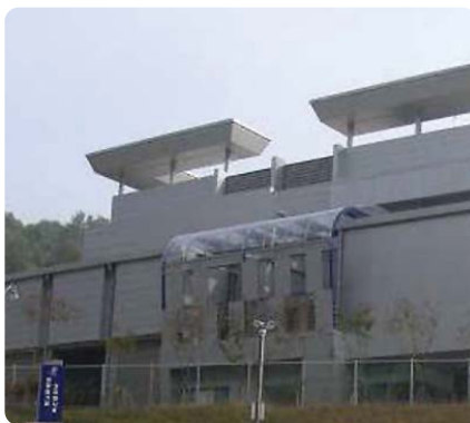
원주시 RDF 생산시설
